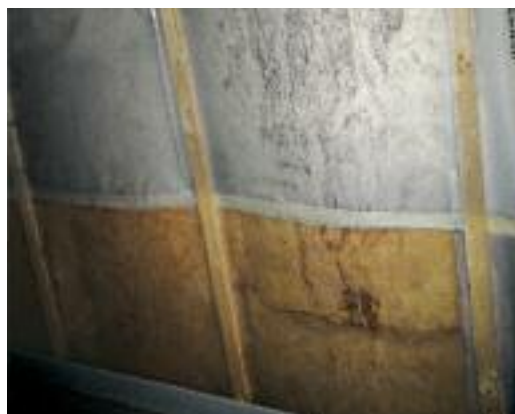
Bojājums izmantojot mitru koksni kopā ar tradicionālu tvaika izolāciju.
