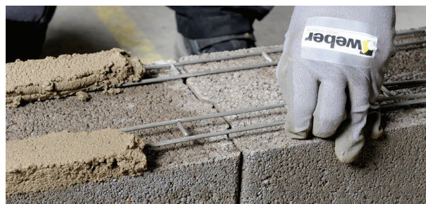
Fibo Efekt ārējo bloku iestrāde
