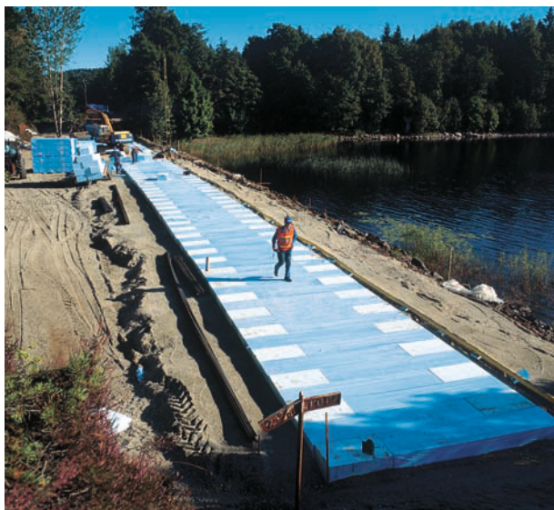
16. att. » Dzelzceļu pretsala izolācija ar STYROFOAM™
