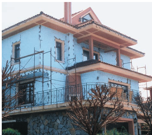
81. att. » Ārsienu izolācija ar STYROFOAM™
