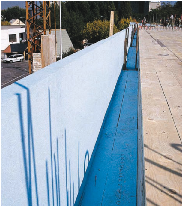
78. att. » STYROFOAM™ loksnes uzstādītas kā ribojums
