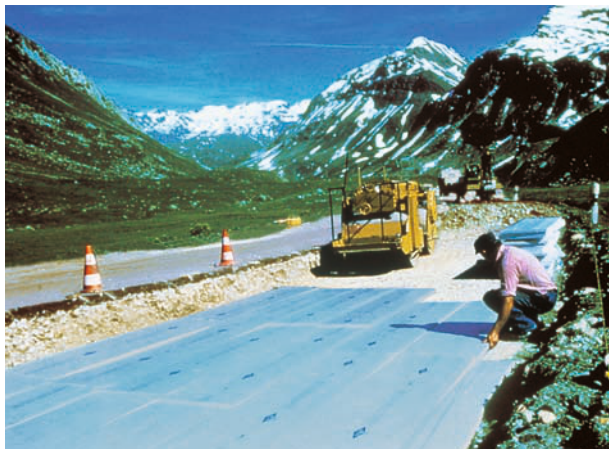
15. att. » Ceļu pretsala izolācija ar STYROFOAM™
