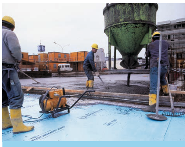
14. att. » STYROFOAM™ mehāniskā izturība betona liešanas laikā
