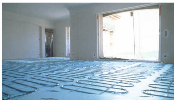
12. att. » Grīdas apkures caurules tieši uz izolācijas materiāla vai attiecīgi uz PE folijas
