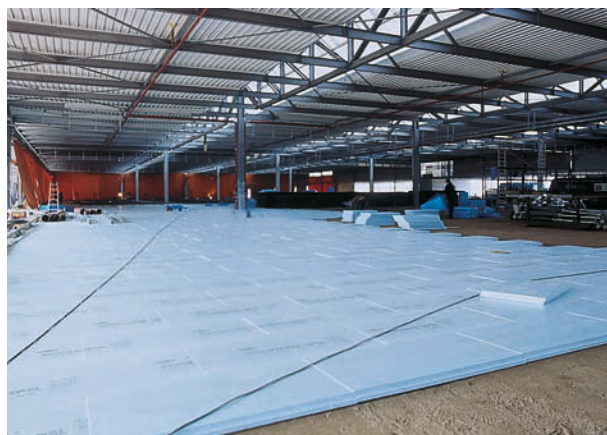
13. att. » Apgrieztās grīdas izolācijas piemērs
