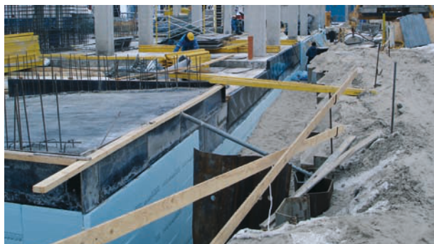
6. att. » Pagraba ārējo izolācija ar daļēju augsnes uzbērumu, izmantojot STYROFOAM™
