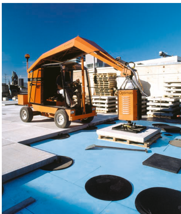
65. att. » Automātiska saliekamo betona panelu novietošana uz distancētājiem
