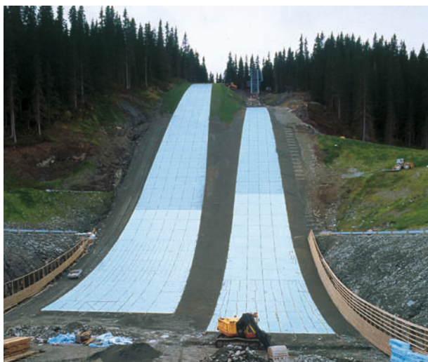
17. att. » Vienkārša, rentabla līdzeno slēpošanas trampīnu izolācija
