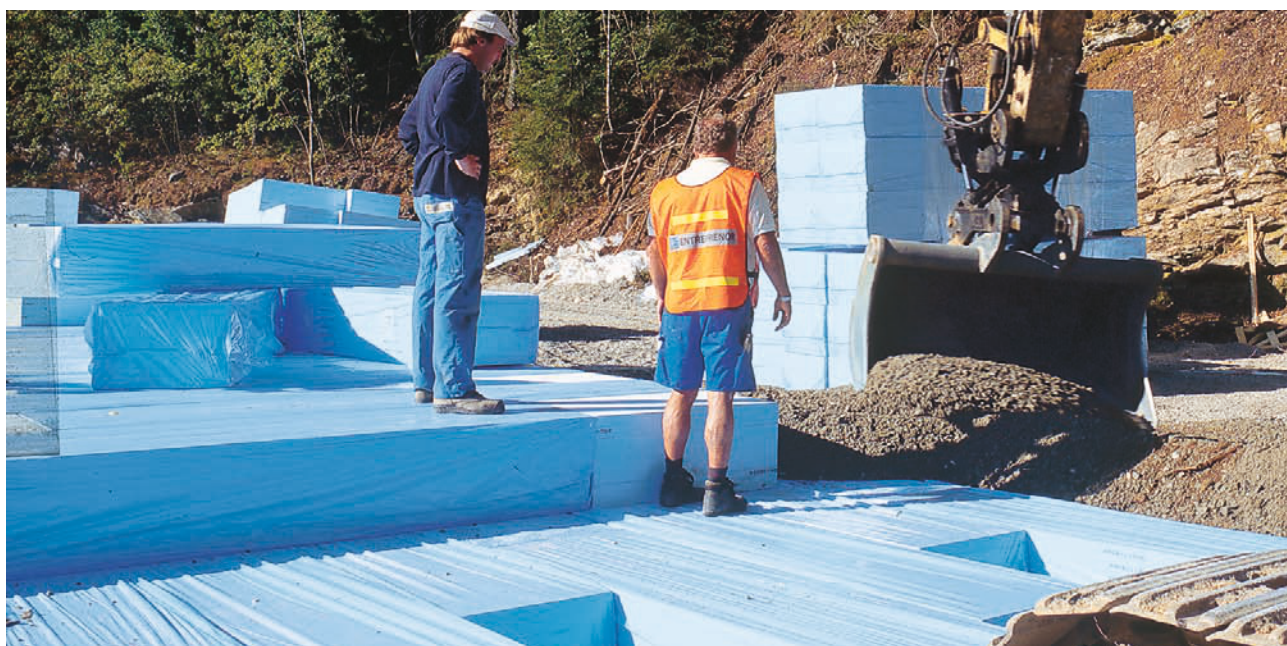
51. att. » Efektīvs STYROFOAM™ pilna komplekta instalācijas kā viegls uzbērumš
