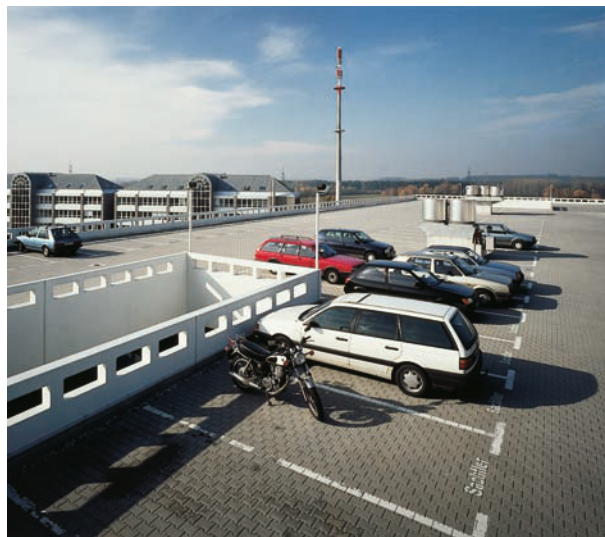
61. att. » Transporta līdzekļu novietne ar cieši savietotiem betona bruģa klučiem
