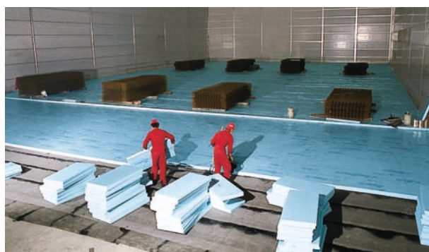
85. att. » Saldētavas grīdas izolācija ar STYROFOAM™ loksēm
