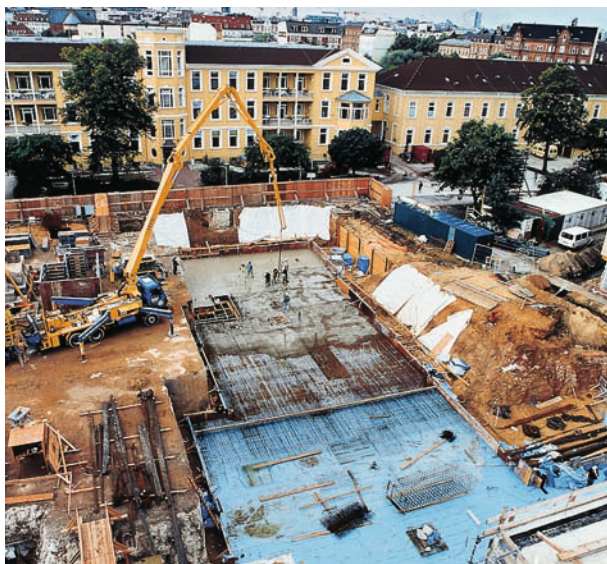
10. att. » STYROFOAM™ izolācija zem slodzi nesošās pamatnes
