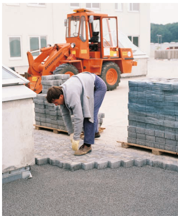
66. att. » Cieši savietots bruģējums uz sapresētas smalkās grants pamatnes
