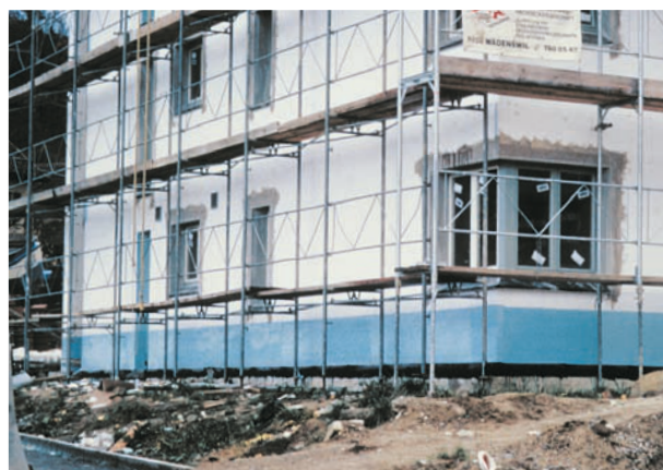
83. att. » Cokols - sienas apakšējā daļa saskarē ar grunti
