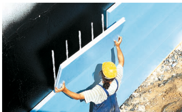
8. att. » Izolācijas perimetra STYROFOAM™ loksnes ar INSTA-STIK™ saistvielu
