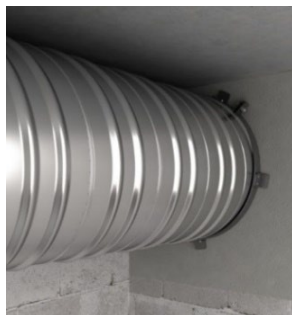
5.4att. Kanāla uzstādīšana, ja kanāla diametrs \varnothing > 400\text{mm}
